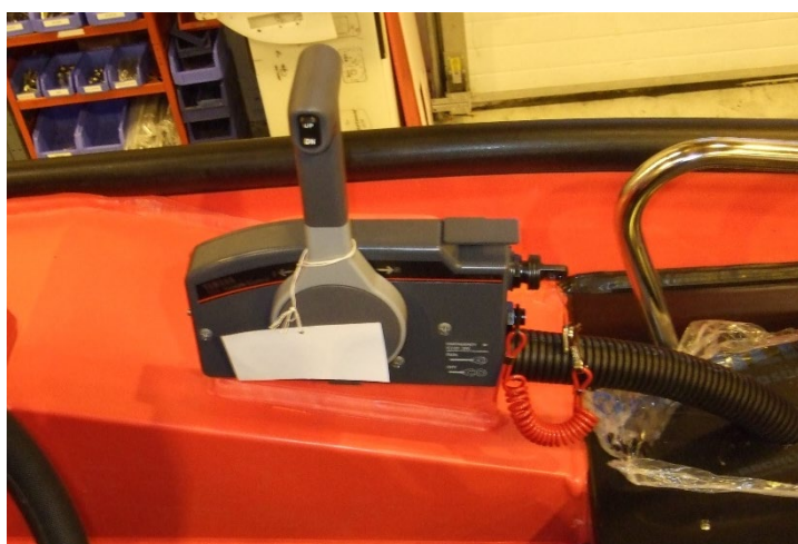
Figur 1 Kablene går ned i bakbenk
