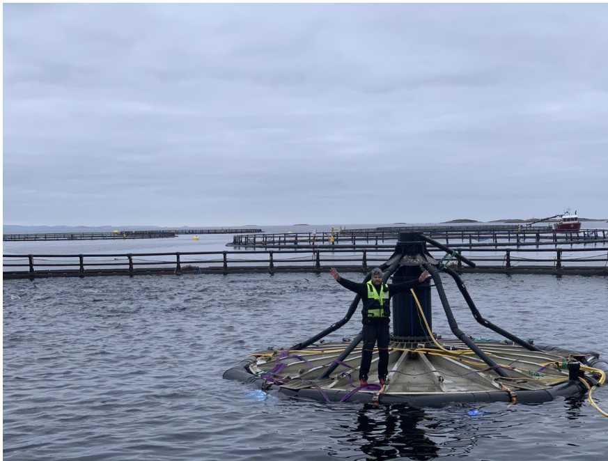
Figur 6 Luftkuppel under montering
