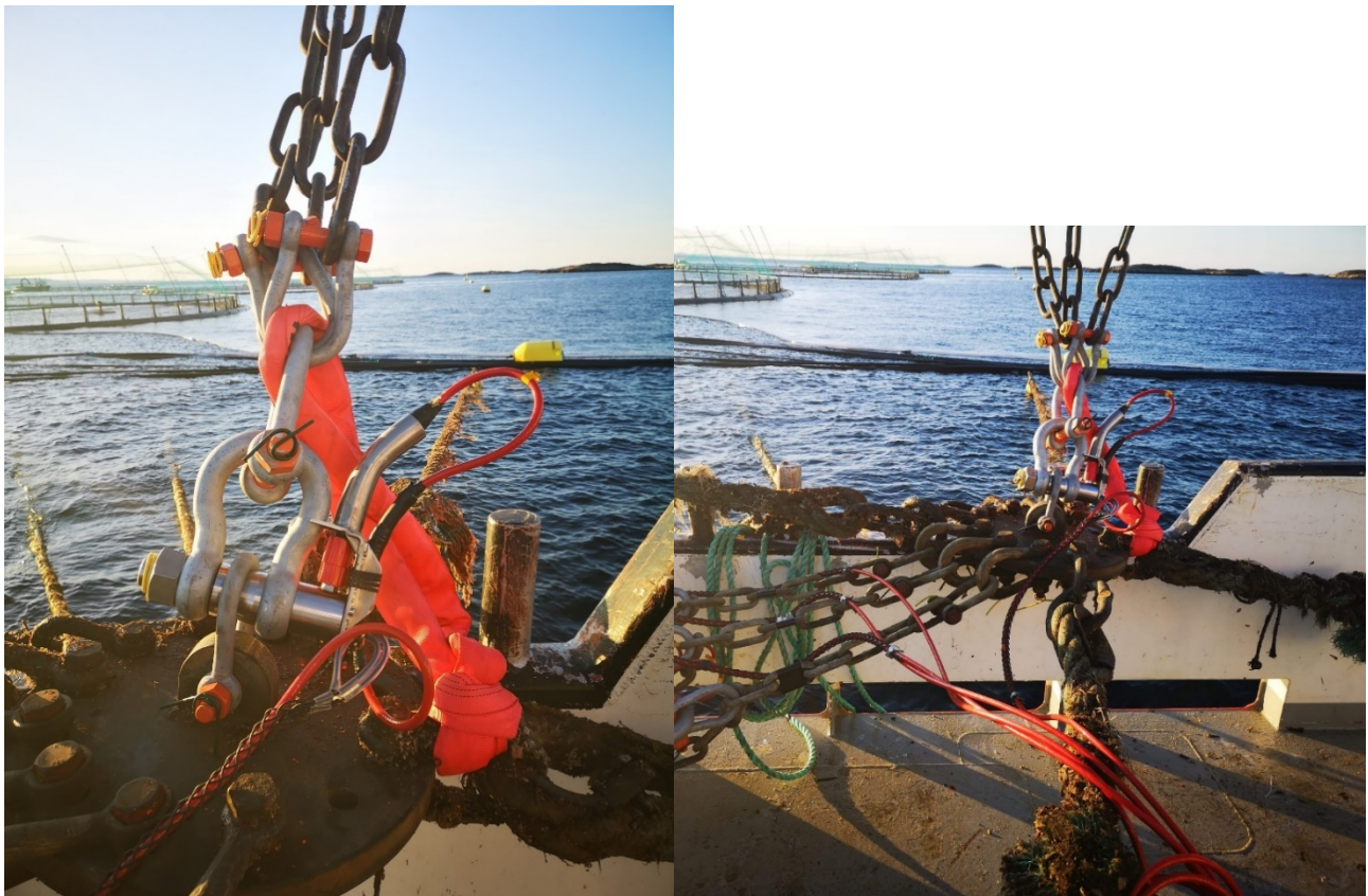
Figur 10 Lastsjakel montert mellom koblingsplate og bøye
