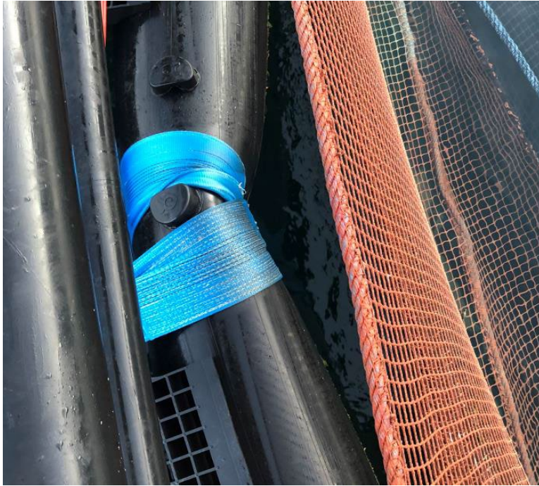
Figur 17 Skade på indre flytrør
